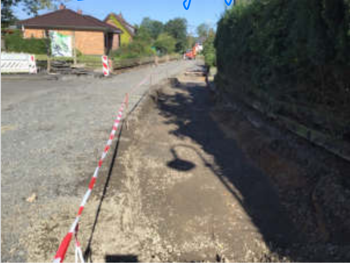
Auskolpungsarbeiten Kanunnug Grabenstr.
