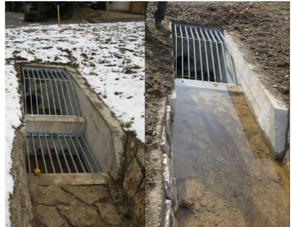
Einlaufbauwerk mit Schlamm- und Geröllfang vor und nach Starkregen
