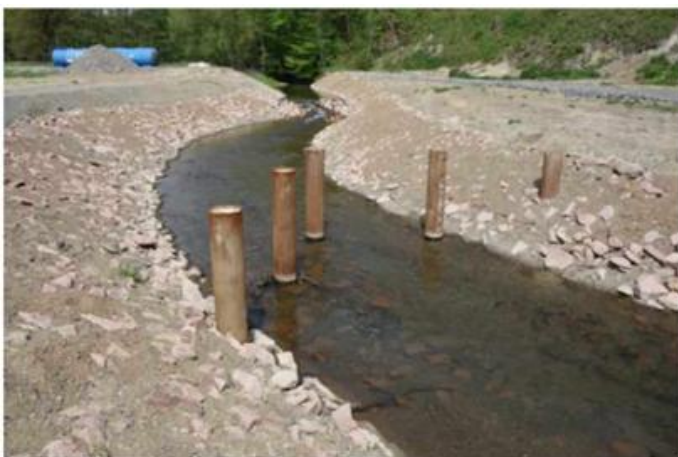
Abbildung 8: V-Rechen im Bereich des HRB Wippra (Eiden 2016).
