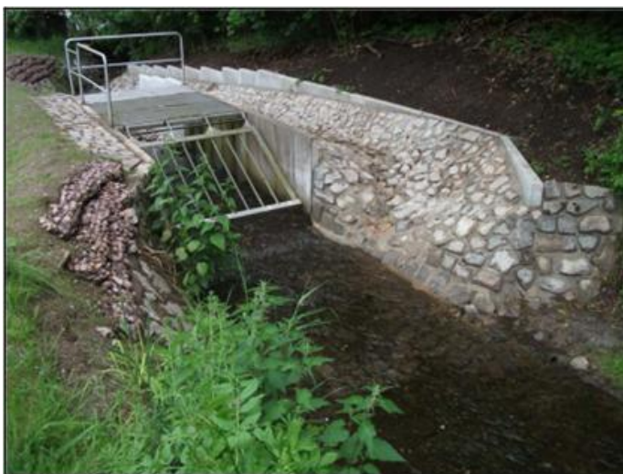
Abbildung 7: Treibgut-/Geschiebefang mit seitlicher Überlaufstrecke (Landeshauptstadt Dresden Umweltamt, 2016).
